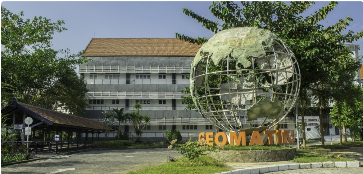
Gedung Departemen Teknik Geomatika ITS.
